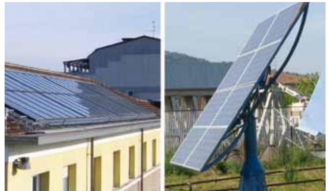
Plusieurs panneaux raccordés électriquement en série constituent une rangée et plusieurs rangées raccordées électriquement en parallèle pour générer l'énergie requise constituent le générateur ou champ photovoltaïque (Figures 1.11 et 1.12).
