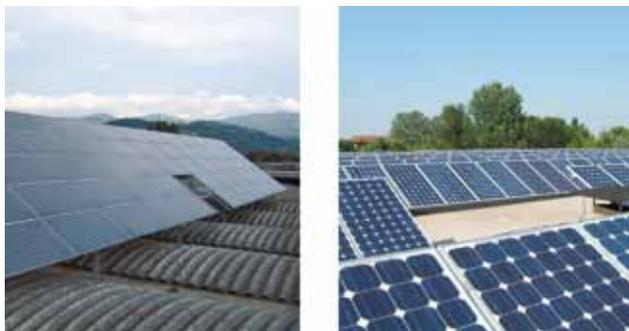
Les installations partiellement intégrées sont des installations dont les modules sont placés conformément aux typologies listées dans le Tableau 3.1 sur les éléments de mobilier urbain, les surfaces extérieures des enveloppes de bâtiment, les bâtiments et les structures à toute fin sans remplacer les matériaux de construction de ces structures (Figure 3.2).
