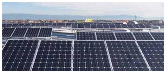
Les cellules PV des modules ne sont pas exactement identiques en raison des écarts de fabrication inévitables ; par conséquent, deux blocs de cellules raccordés en parallèle peuvent avoir des tensions différentes. Un courant circule alors du bloc de cellules ayant une tension supérieure au bloc de cellules ayant une tension inférieure. Une partie de l'énergie générée par le module est donc perdue dans le module lui-même (pertes par dissipation).
