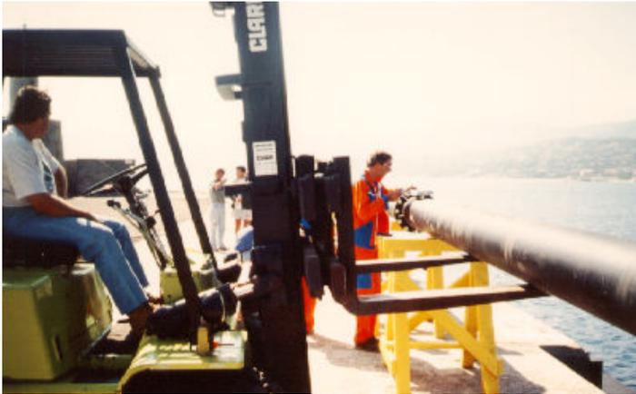
Fig. 5 - Manutention à l'aide d'un chariot élévateur, des tubes. Montage et boulonnage des brides à la clef à chocs.
