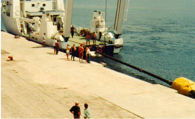
Fig. 14 - Amenée de la balise par flottaison -allégée par le portique du baliseur -, au contact du corps-mort.
