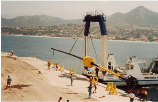
Fig. 10 - Manutention de la balise depuis le quai, et mise à l'eau par le portique du baliseur.
