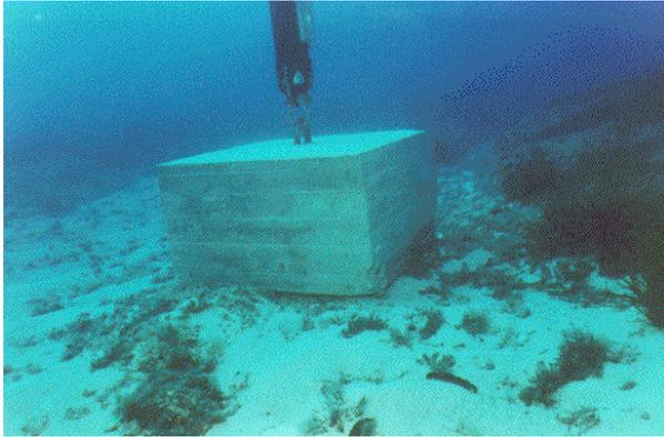
Fig. 19 - Corps-mort reposant sur un fond de sable, remarquer sur la droite la barre rocheuse (-30,00 m).
