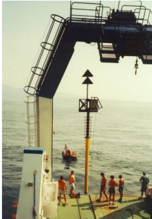
*Fig. 18 - Opération de mouillage de la balise, descente progressive du corps-mort.*
