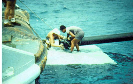
Fig. 15 - Opération de manillage, puis matage de la clavette de verrouillage de la manille.
