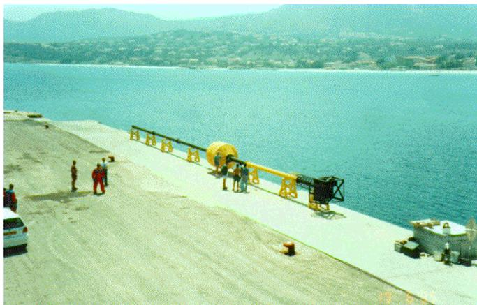
Fig. 9 - Balise et corps-mort en bord de quai, en attente.
