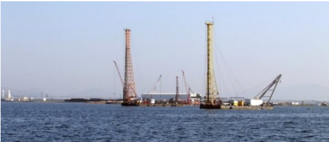
Les travaux, prise de vue Laorana juillet 2013
